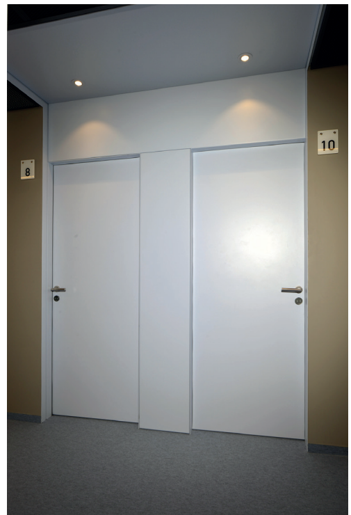
Individuallösung: Zur Unterstreichung des Nischen-Charakters wird die Optik der dezenten Türrahmen bis in die Decke fortgeführt. Bild 47c01574
