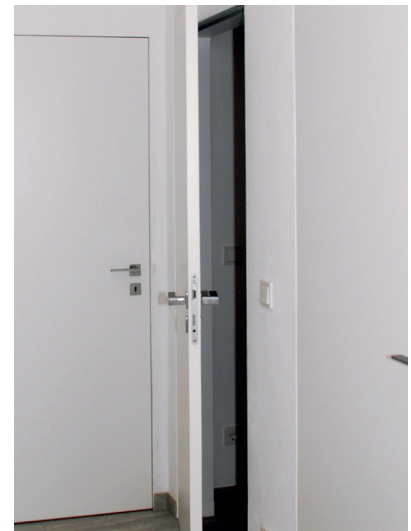
... mit nahezu unsichtbaren Tür­rahmen ... (Bild 47c91297)
