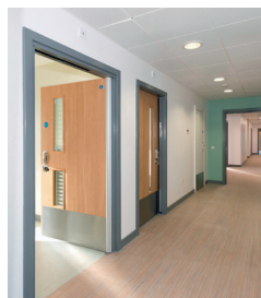
Safehinge-Stahlzargen für den Mental Health Bereich
