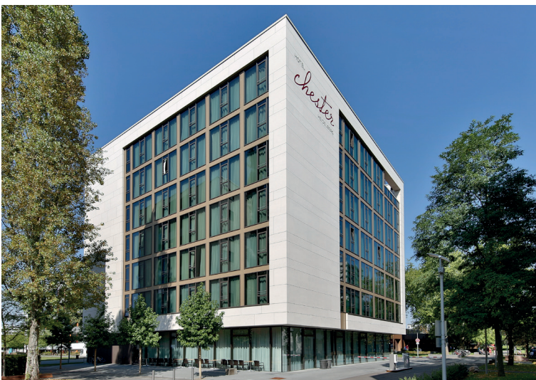
Markant und kubisch: Das neue Hotel Chester Heidelberg. Bild 47c01531
