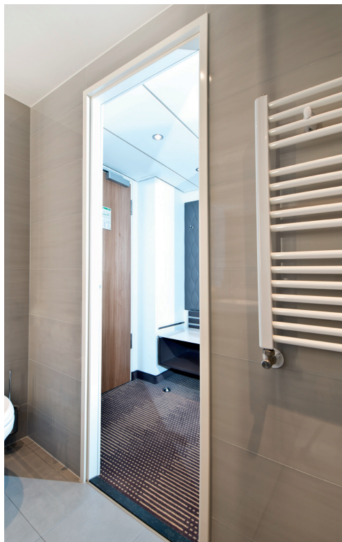
EasyFix Stahlzargen für eine schnelle und saubere Montage während des laufenden Hotelbetriebs. Bild 47c01588
